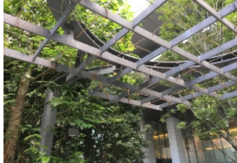
屋外パーゴラ鉄骨
