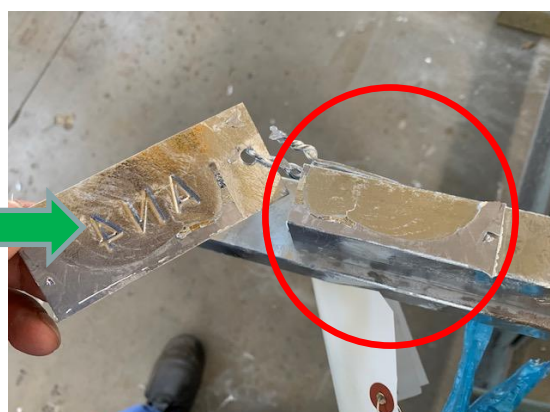
金札を剥がすと表面に剥離発生
