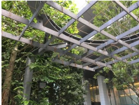
屋外パーゴラ鉄骨
