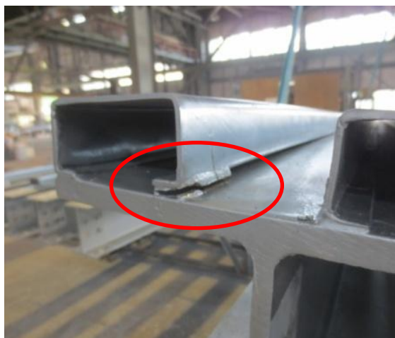
板厚差に起因した溶接割れ
