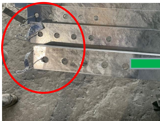
番線に遊びがなく動かせない
