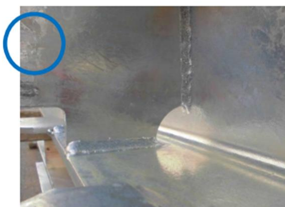
鉄骨工事Q&A A-7-5 めっき抜き孔の形状より抜粋
